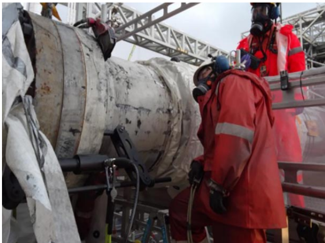
Bilde 11: Entring av separator. Yrkeshygieniker til høyre måler før entring av separator.
