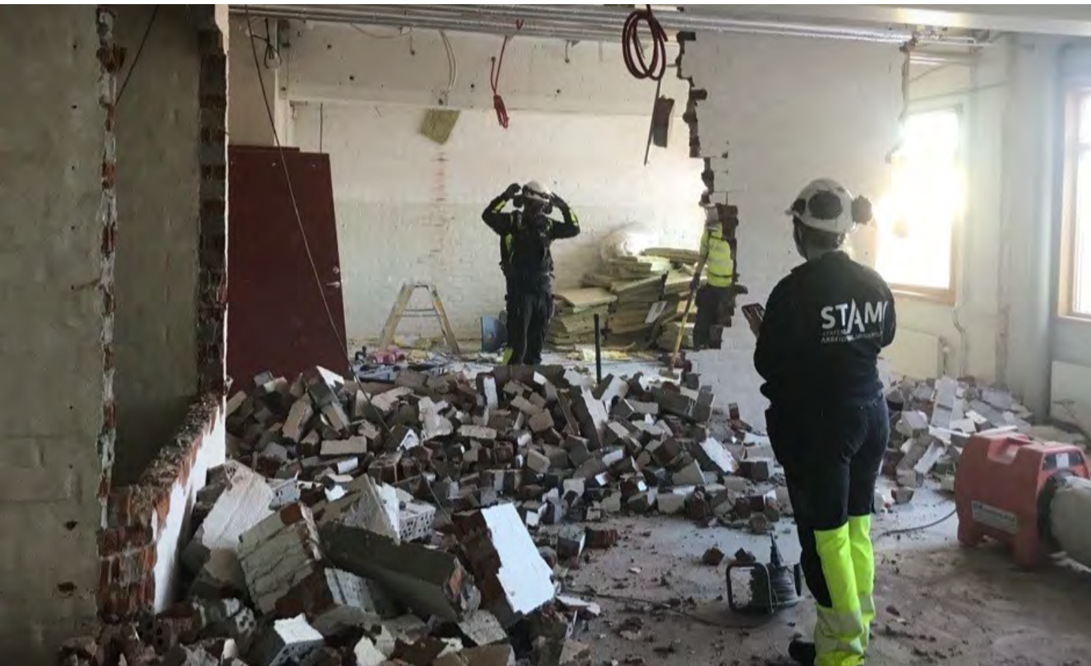
STAMI har samla luftprøver fra rivingsarbeid på 14 byggeplasser. (Foto: STAMI)
