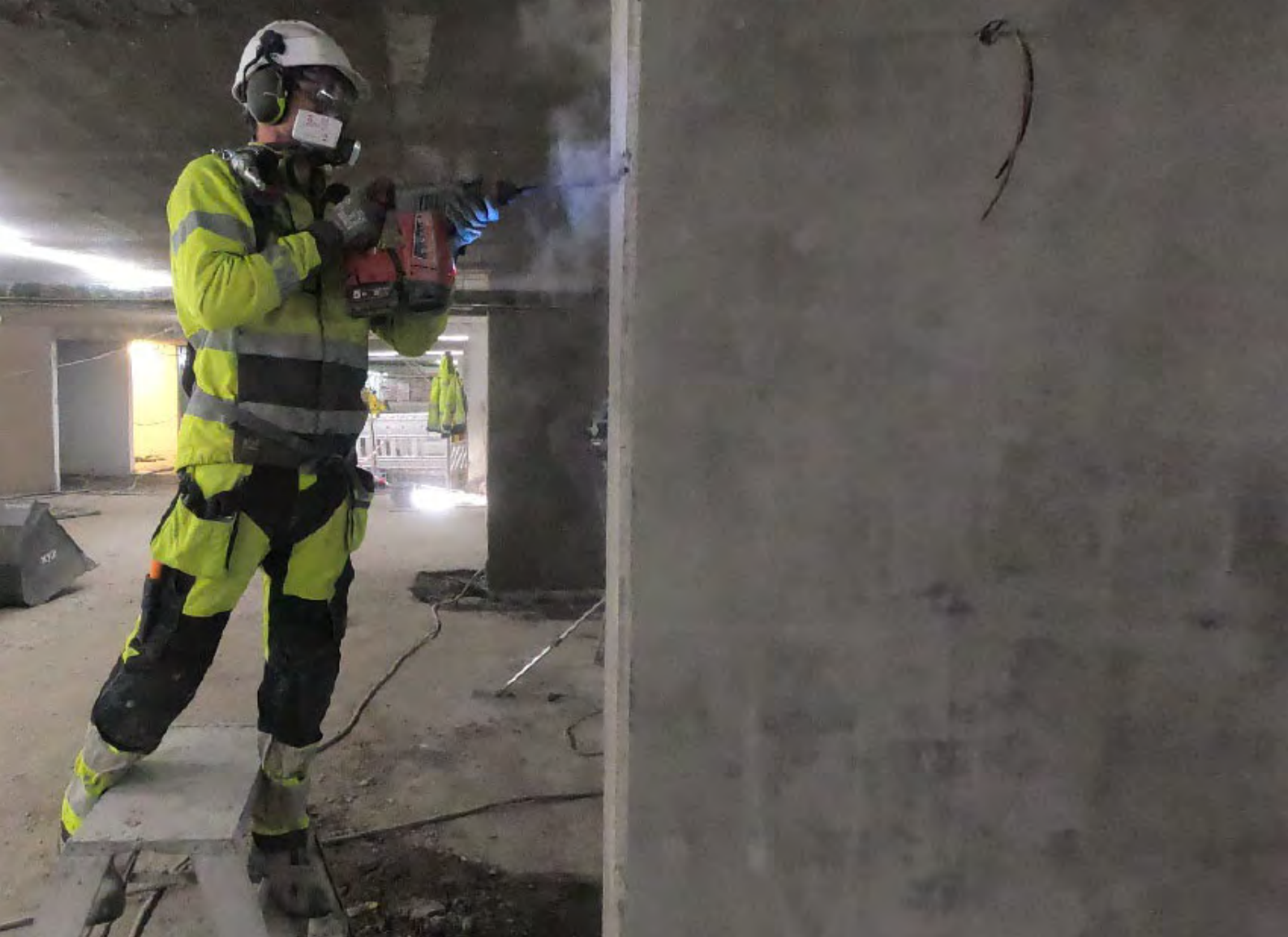
Pigging av betongvegg for å komme inn til armeringsjern. Foto: STAMI
