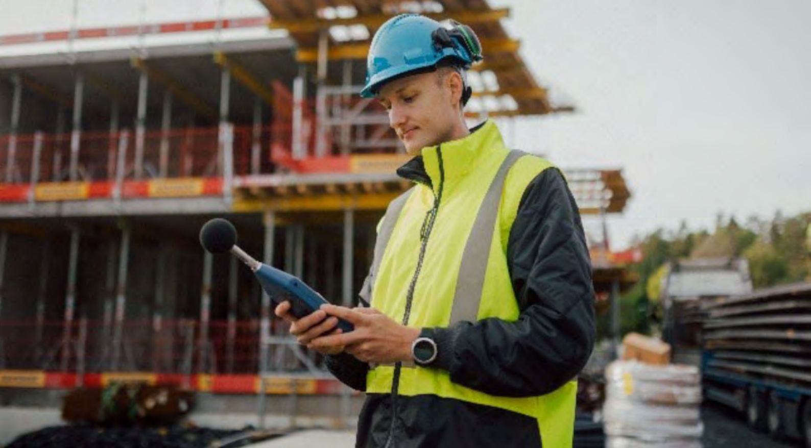
Måling av støy på arbeidsplasser. Foto: Norsonic.
