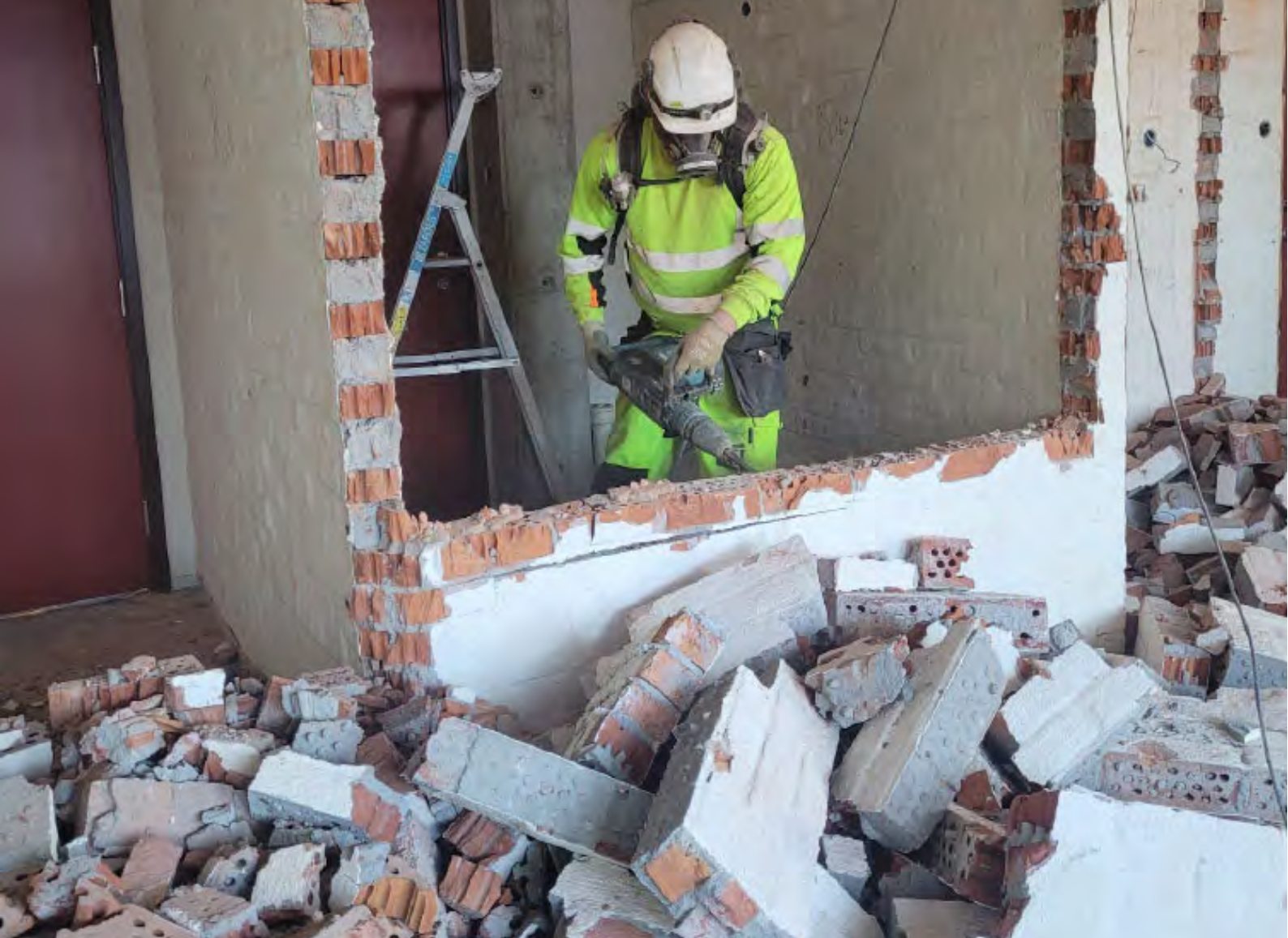
Riving av teglsteinsvegg ved hjelp av håndholdt piggmaskin. Foto: STAMI
