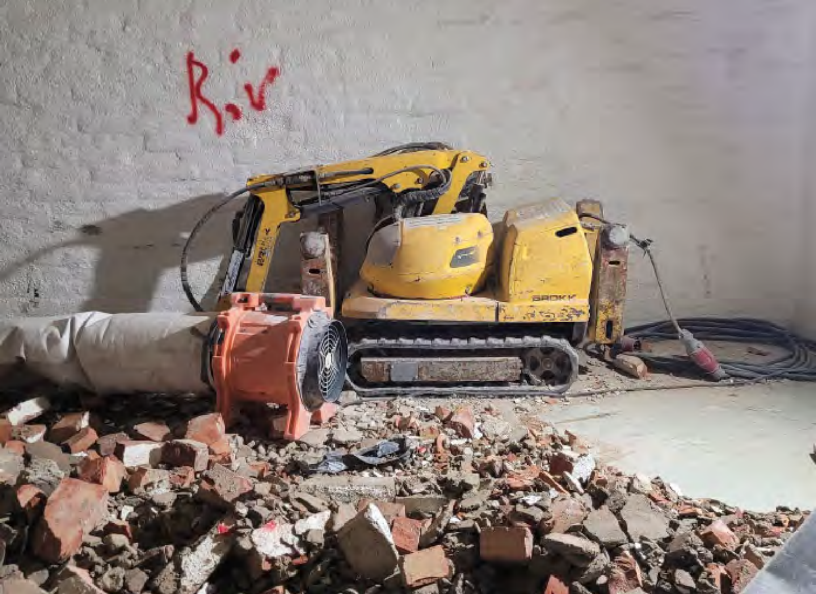
Teglsteinvegg klar til riving med fjernstyrt piggemaskin. Ventilasjonsvifte med tilhørende støvpose er også synlig. Foto: STAMI
