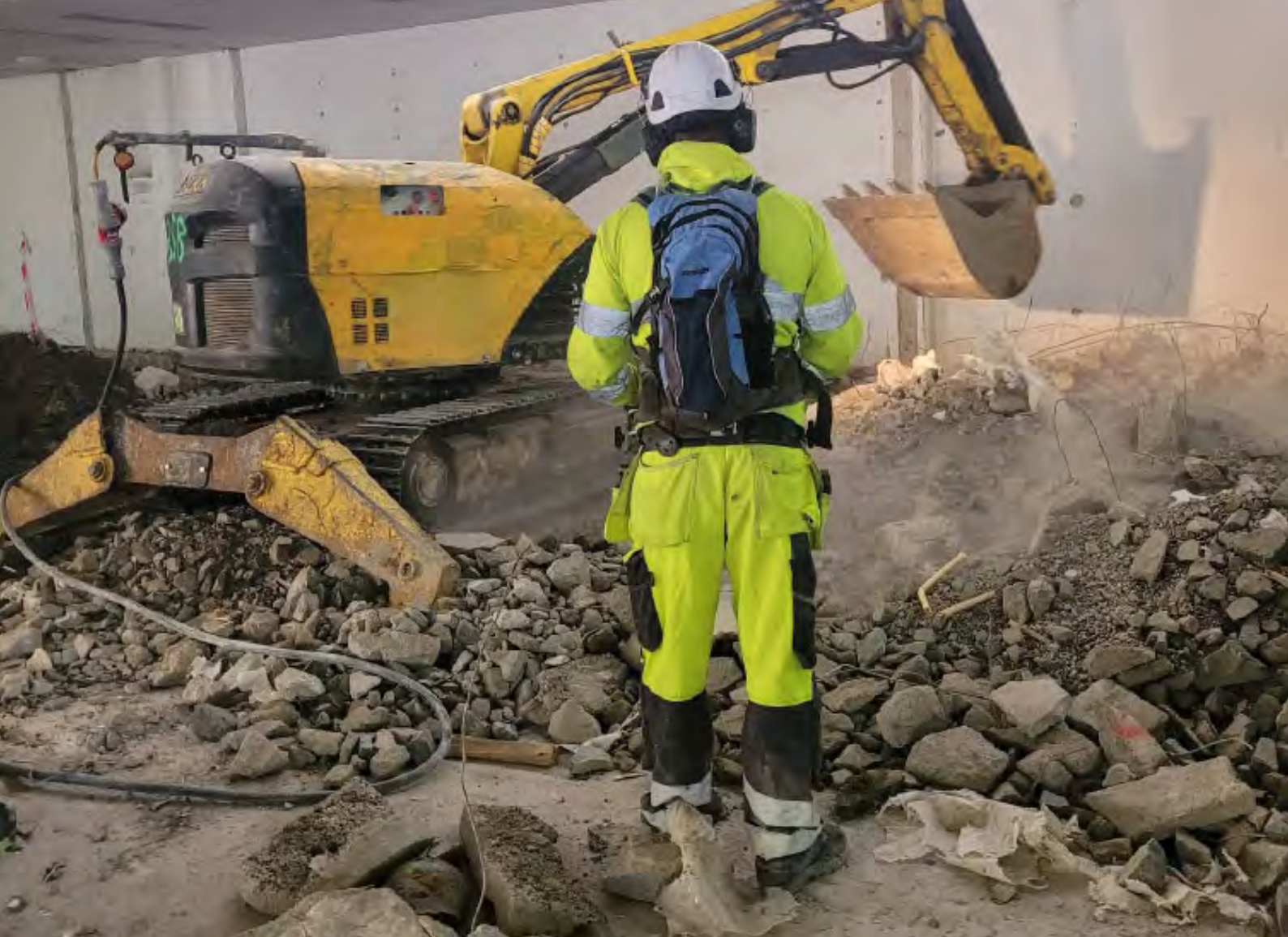
Innendørs fjerning av revet betonggulv med graver. Foto: STAMI
