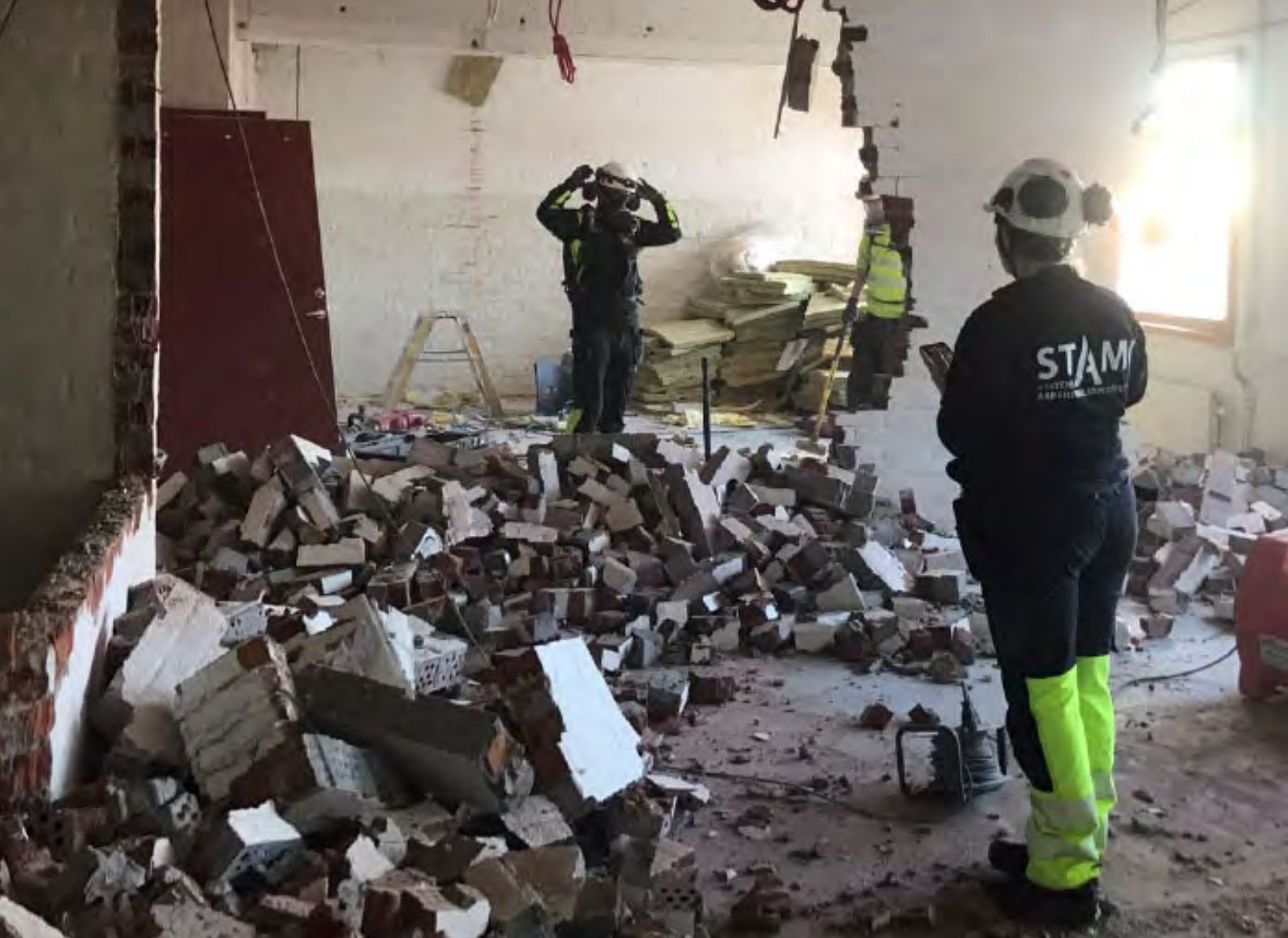
Innvendig riving av teglsteinsvegger. Ventilasjonsvifte med tilhørende støvpose i høyre hjørne. Foto: STAMI
