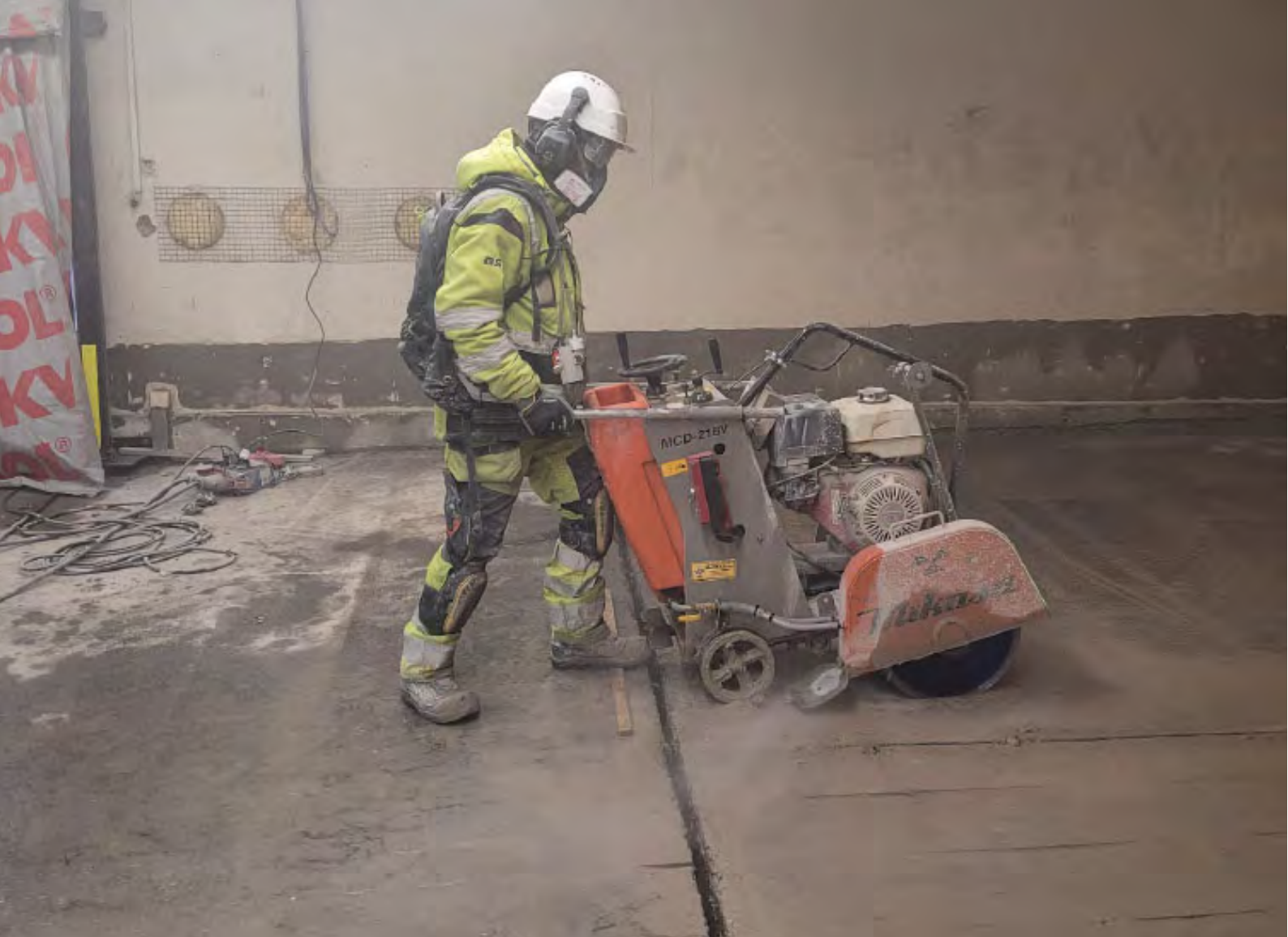
Betongskjæring av fuktig betong. Foto: STAMI
